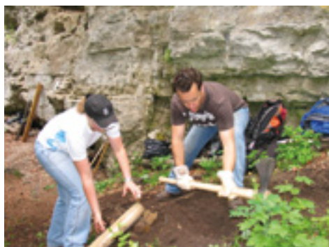
Steigsanierung zur Vermeidung von Erosionsschäden
